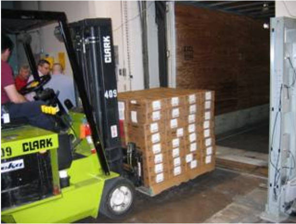
Dock Door RFID Portal
